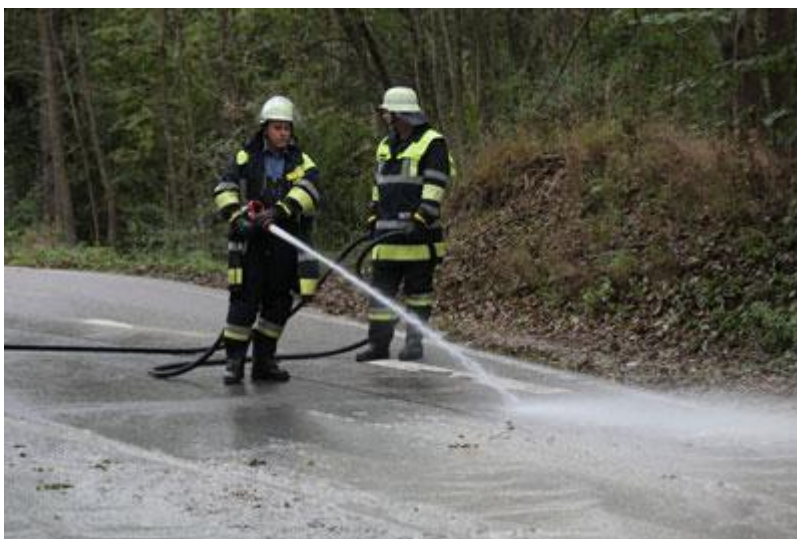
Reinigungsarbeiten der Verkehrsfläche am Pürtener Berg. LKW verlor Ladung. Es handelte sich dabei um Bohrschlamm.
